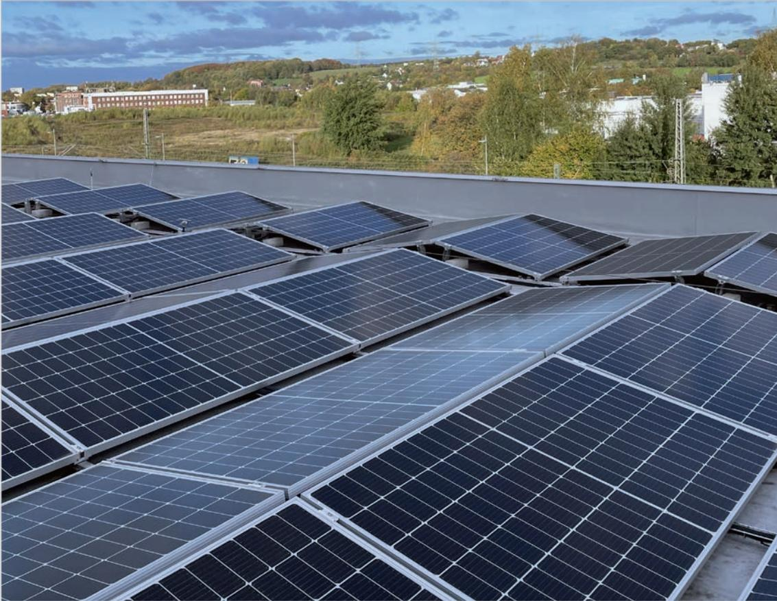
Ardex rechnet mit mehr als 570.000 kWh Ertrag, was ungefähr dem Verbrauch von 160 Haushalten entspricht. Im ersten Quartal des kommenden Jahres soll der Ausbau zudem weitergehen. Auf dem Dach von Werk 2 werden dann rund 1.750 Quadratmeter Solar-Panels installiert.
