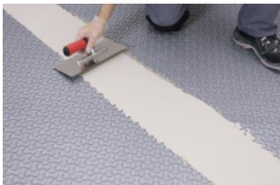
1. Verklebung der ARDEX FLEXBONE auf dem Untergrund mit ARDEX X 78. Dichtkleber ARDEX 7+8 wird auf die Stoßbereiche von ARDEX FLEXBONE® bzw. an die Anschlussbereiche angrenzender Bauteile aufgebracht.
