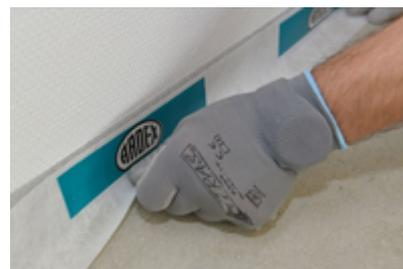
3. Entlang aufgehender Bauteile und Belagsdurchdringungen ist der ARDEX TP 50 Randdämmstreifen, zu stellen.
