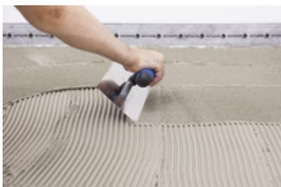
4. Klebstoff mit geeigneter Zahnleiste TKB B3 - B10 auftragen. Alternativ kann der empfohlene Bodenbelagskleber aus der Aufbauempfehlung verwendet werden.
