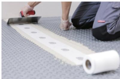
2. Entsprechende Systemdichtbänder aus dem ARDEX TRICOM System, Dichtbandecken, -Manschetten etc. werden frisch in den Dichtkleber eingebettet und überarbeitet.
