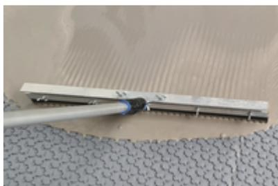
10. Anschließend wird die ARDEX FLEXBONE® mit einer fließfähigen Bodenspachtelmasse wie in der Aufbauempfehlung angegeben nach Herstellervorgabe verspachtelt. (Mindestüberdeckung 5mm)
